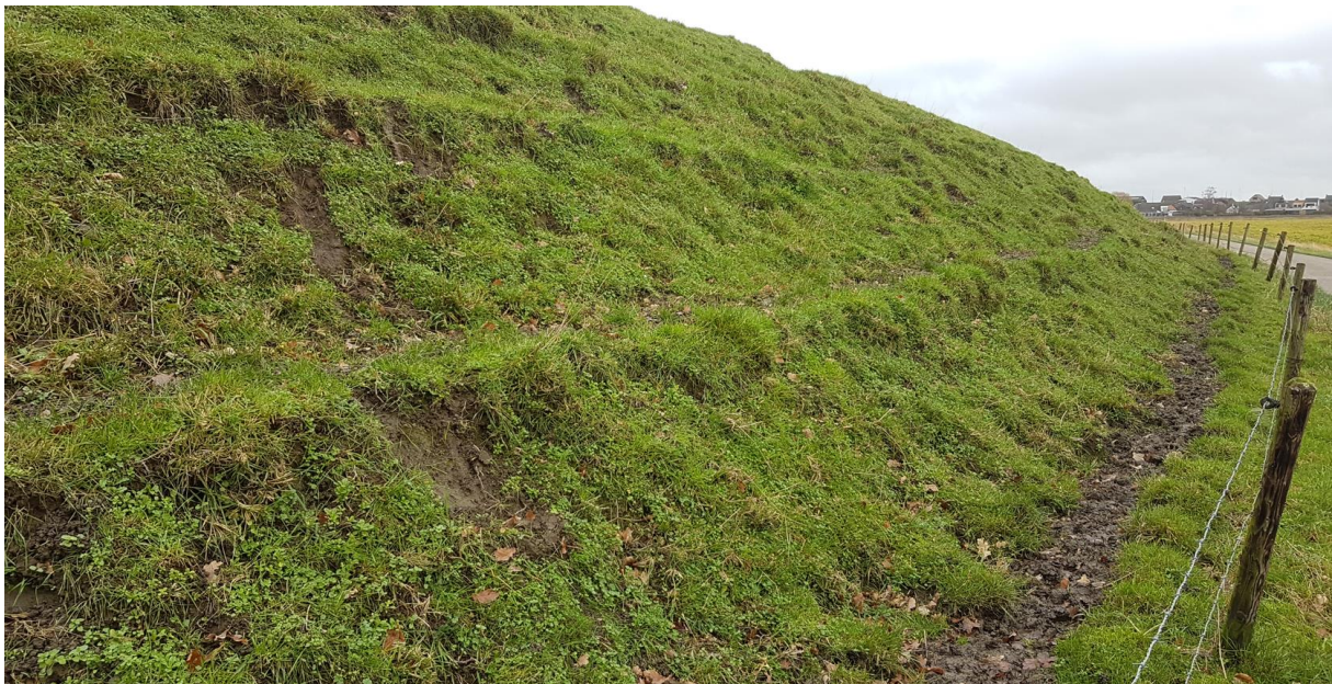
Figuur 7.1. Een dijktalud met veel bodemreliëf in de vorm van oude veepaadjes.
