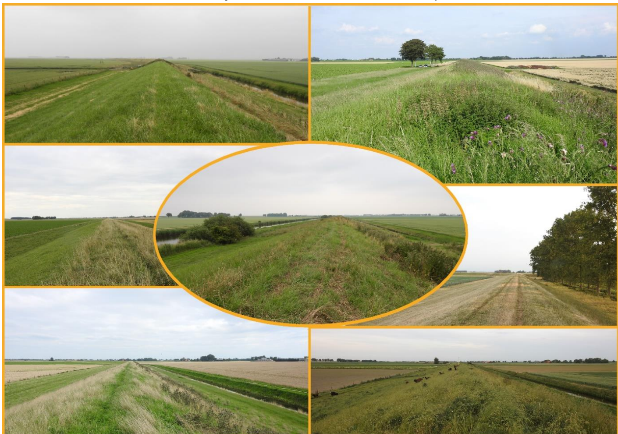
Voorbeelden van dijkvakken van niet-deelnemers aan de pilot. © GKA
