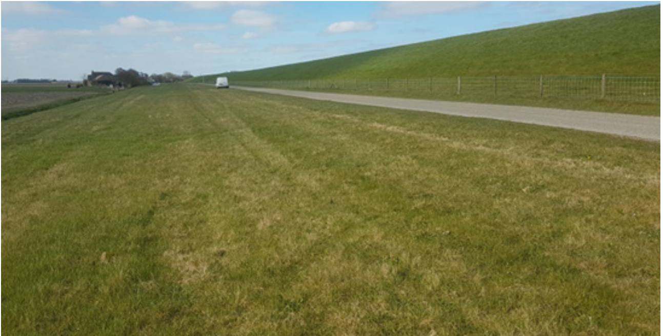
De ecologisch beheerde berm en aanliggende dijk bezitten weinig structuurvariatie. 8 april 2025, locatie E.
